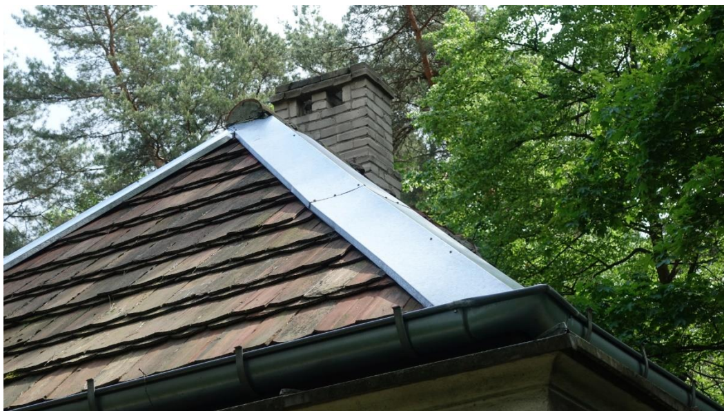
Kalenice narożne pokryte tymczasowo obróbką blacharską
