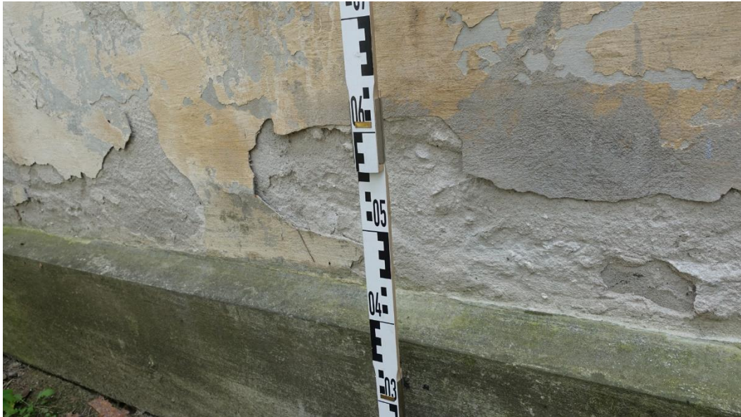
Wysolenia do wysokości 60 cm od poziomu terenu
