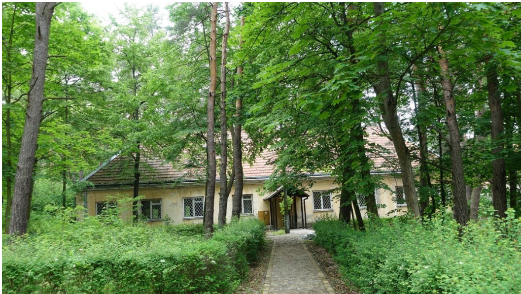
Widok ogólny budynku od strony południowej
