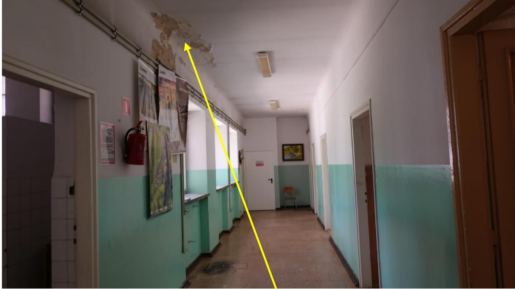
Korytarz z widoczną destrukcją w wyniku działania wilgoci
